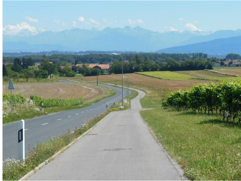
Figure 39 : Photographie, piste cyclable sur le réseau routier de campagne
