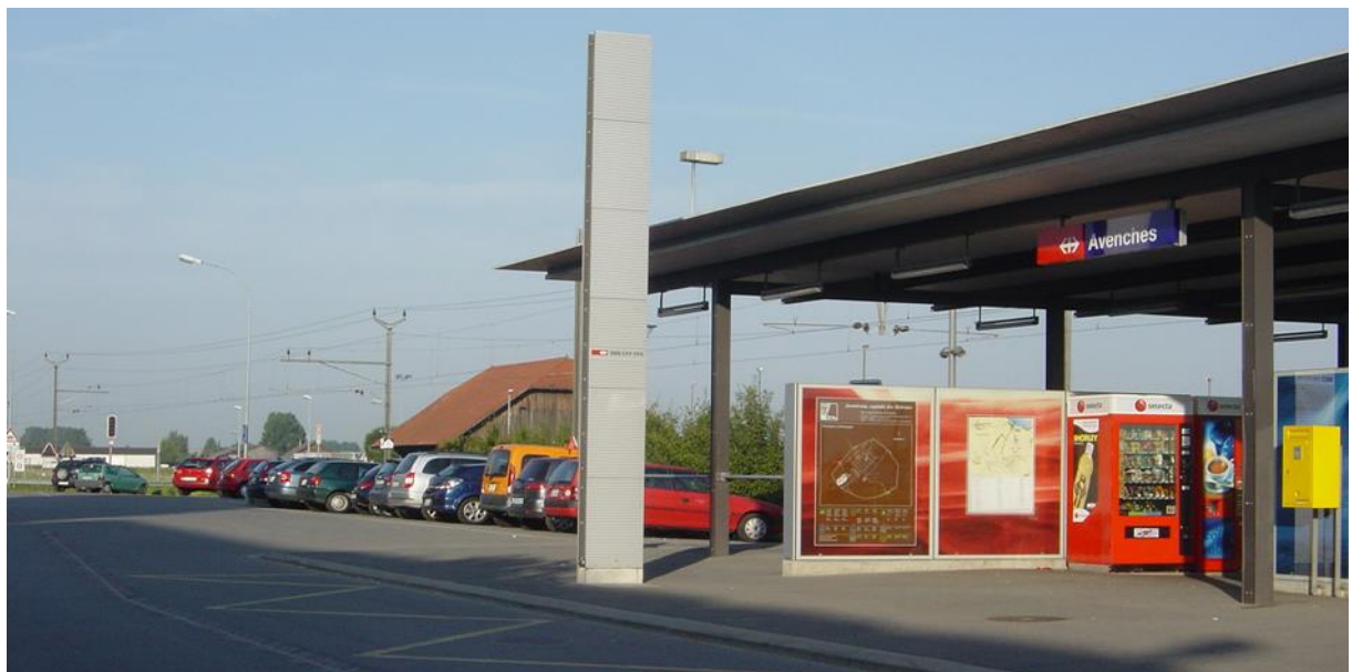
Figure 41 : Photographie, parking-relais à la gare d'Avenches
